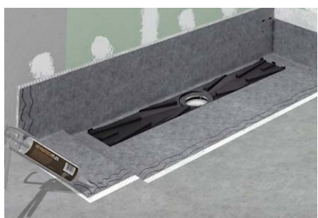
14. Aplicar un cordón de adhesivo REVESTTECHFLEX antes de solapar la lámina del resto de la ducha.
