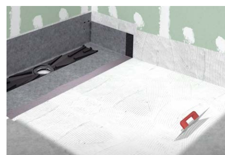
16. Recubrir el suelo de la ducha con cemento cola C2 S1/S2 y adherir la lámina ECODRY50 incluida en el kit.
