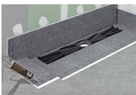
14. Aplicar un cordón de adhesivo REVESTTECHFLEX antes de solapar la lámina del resto de la ducha.
