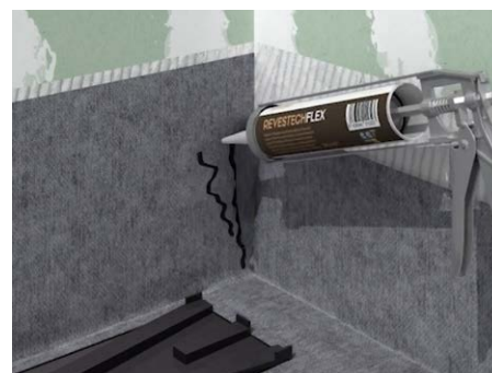
13. Formar las esquinas plegando la lámina. Aplicar REVESTTECHFLEX para pegar el pliegue.
