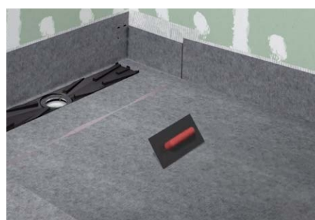
15. Comprobar que la lámina esté bien extendida y sacar el aire que se pueda haber generado con ayuda de la llana.
