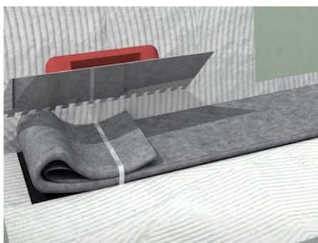
11. Adherir con cemento cola clase C2 S1/S2 sobre encuentros y pendientes la banda ECODRY BANDA termosellada al LINEAL/SUMI LEVEL .
