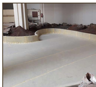
Impermeabilización de los jardines interiores con DRY80 , diseñados por César Manrique, del HOTEL PARADISUS SALINAS. Costa Teguise (Tenerife).
