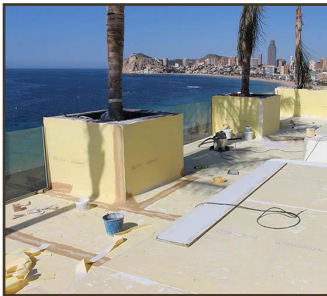
Impermeabilización piscinas con DRY120 . OCEAN DRIVE APARTMENTS. Benidorm (Alicante).
