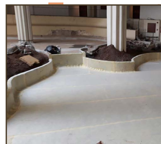
Impermeabilización de los jardines interiores con DRY80 , diseñados por César Manrique, del HOTEL PARADISUS SALINAS. Costa Teguise (Tenerife).
