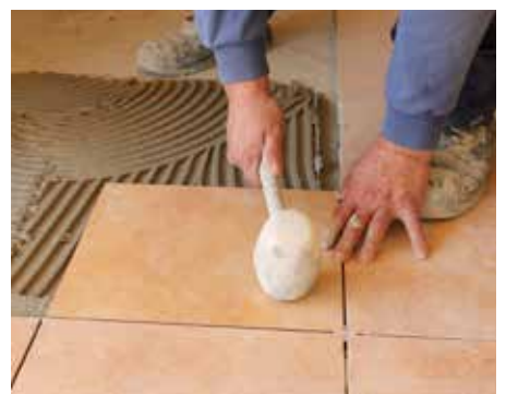
9. Colocar el pavimento directamente con cemento cola C2 y fijar el rodapié.
