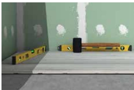
INSTALACIÓN DEL PLATO
