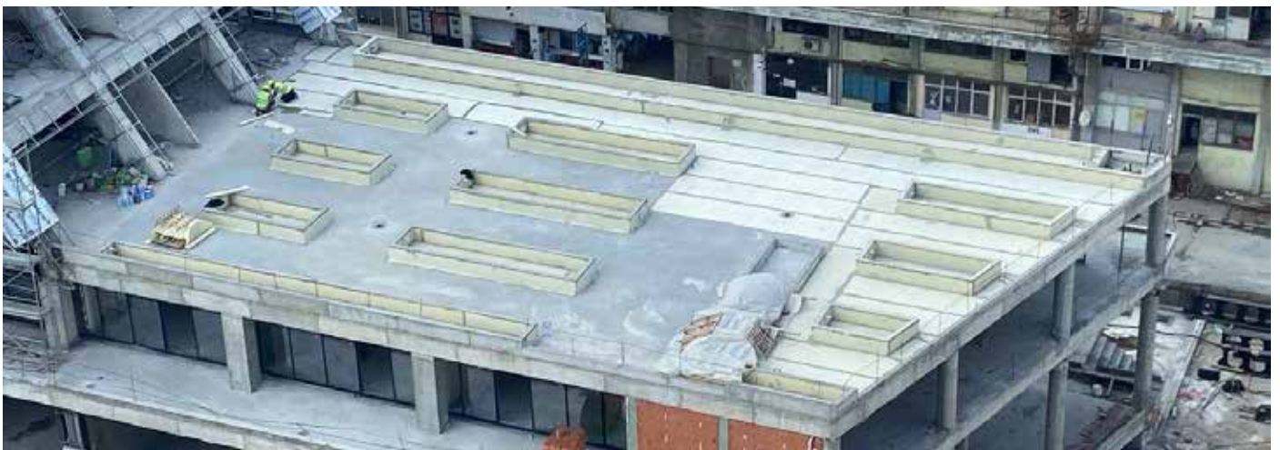
Impermeabilización de 20.000 m 2 de DRY120 en todas sus terrazas transitables exteriores. ISTMALL ESTAMBUL. Edificio para oficinas, universidad y centro comercial. Estambul. Turquía.
