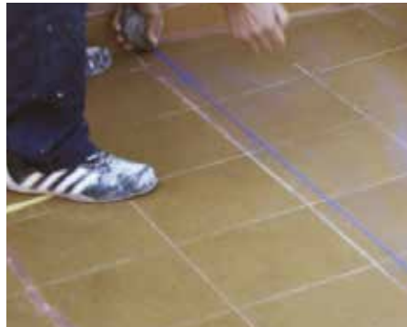
2. Replanteo, medición y corte de los paños.
