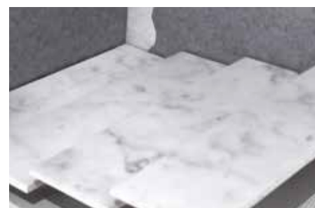
19. Proceder al pavimentado del plato, comenzando desde los aleros y tomando siempre como guía la pieza del LINEAL/SUMI LEVEL .
