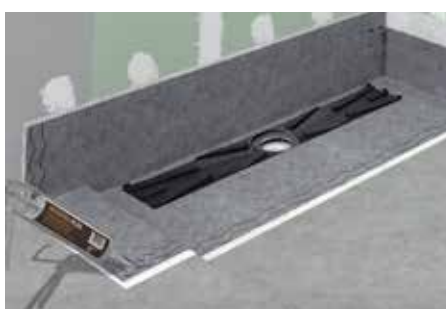
14. Aplicar un cordón de adhesivo REVESTTECHFLEX antes de solapar la lámina del resto de la ducha.
