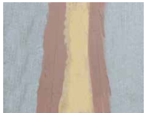
6. Sellar la banda DRYBANDA 13 con otra pasada de adhesivo SEALPLUS (doble sellado).
