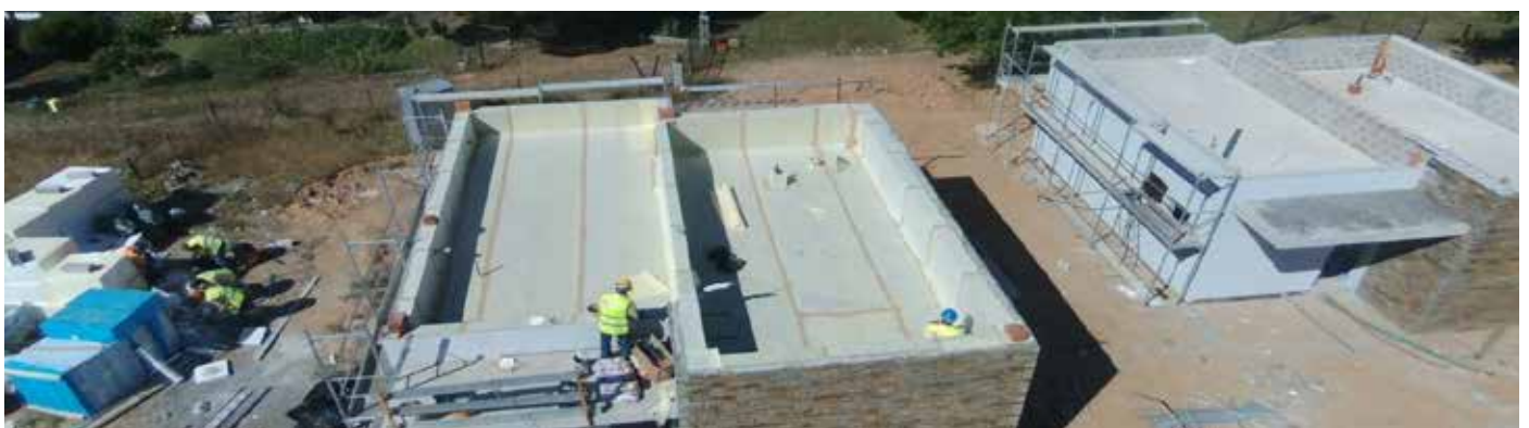
Impermeabilización de las cubiertas con DRY80 . RESIDENCIA DE 3ª EDAD EN LENSTISCAIS. Castelo Branco. Portugal.
