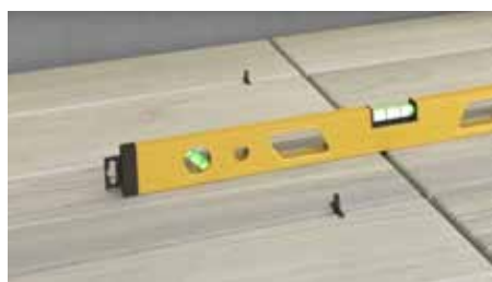
INSTALACIÓN DEL SUELO DEL BAÑO
