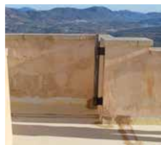
Impermeabilización de almenas y cubiertas con DRY80 del CASTILLO DE COCENTAINA. Alicante. España.
