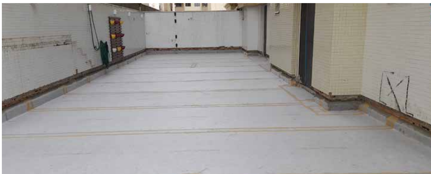
Impermeabilización de 700 m 2 con ECODRY120 en todas sus terrazas transitables exteriores. Condominio en Itapema. Brasil.
