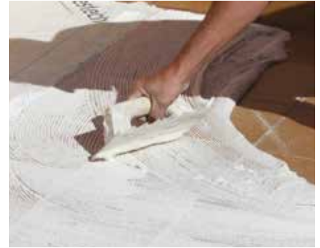
3. A continuación aplicar cemento cola clase C2 S1/S2 con llana dentada de 6/8 mm. Aplicar el adhesivo en pequeños paños para evitar que se seque y siempre peinando en un único sentido. En ningún caso instalar la lámina sobre un cemento cola semi fraguado. NOTA: en rehabilitación, aplicamos el cemento cola clase C2 S1/S2, directamente sobre el pavimento antiguo.
